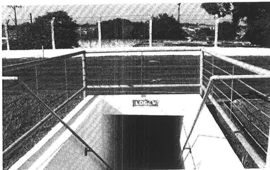
foto 2 - entrada do túnel do vestiário local
