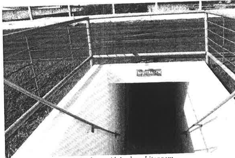
foto 6- túnel de entrada do vestiário da arbitragem
