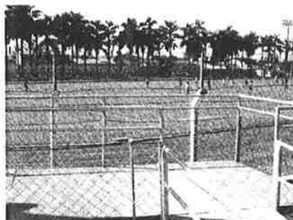
foto 20 - estrutura reservada para os PCR
