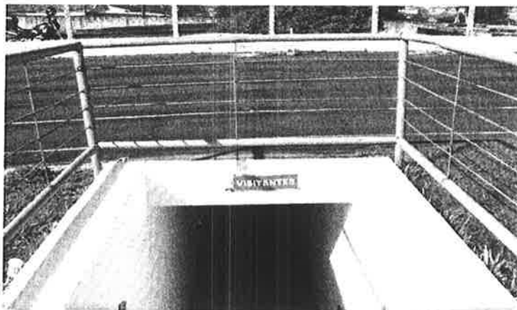
foto 9 - túnel de entrada do vestiário dos visitantes
