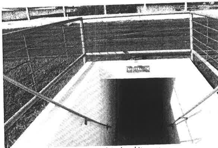
foto 6- túnel de entrada do vestiário da arbitragem
