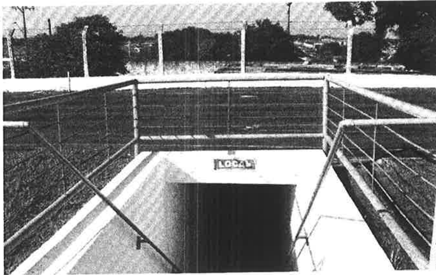
foto 2 - entrada do túnel do vestiário local
