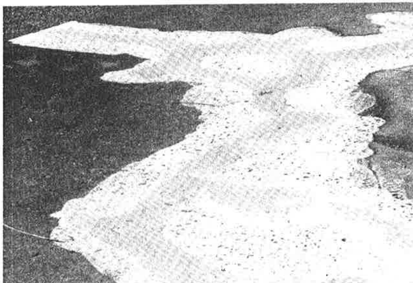
foto 12 –manutenção da camada de proteção mecânica com produto impermeabilizante
