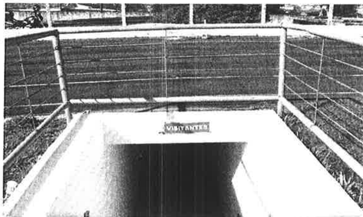
foto 9 - túnel de entrada do vestiário dos visitantes
