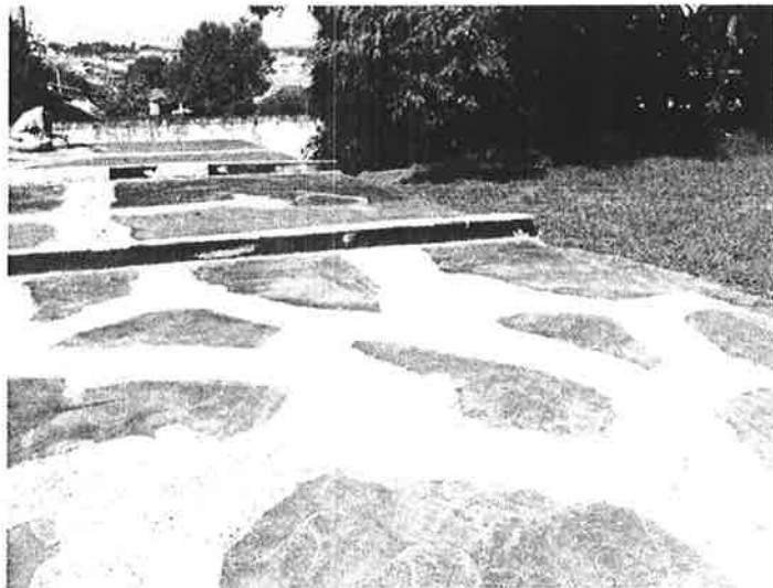
foto 11 - laje de cobertura dos vestiários recebendo manutenção da impermeabilização
