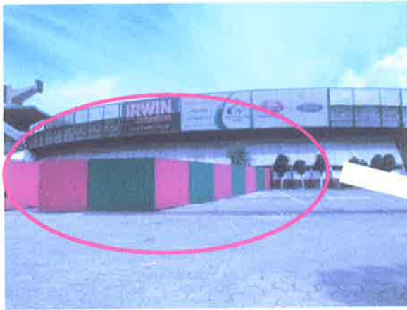
Foto 7 – Placas de aço que isolam o estádio
