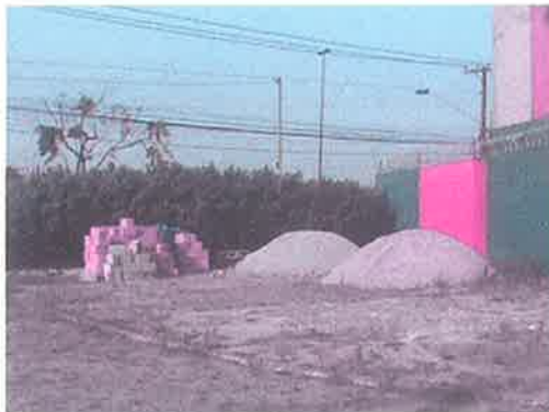
Foto 27 – Materiais de Obra
