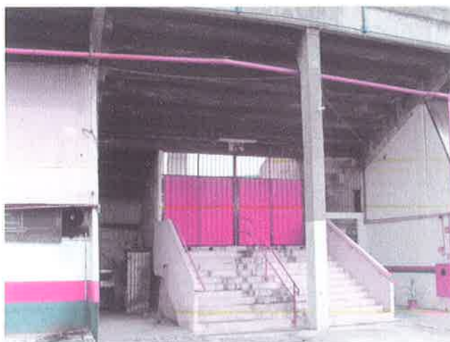
Foto 6 – Placas de aço fechando o Portão 6
