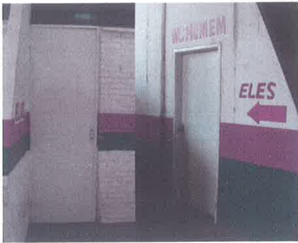
Foto 25: Banheiro feminino e masculino setor visitante
