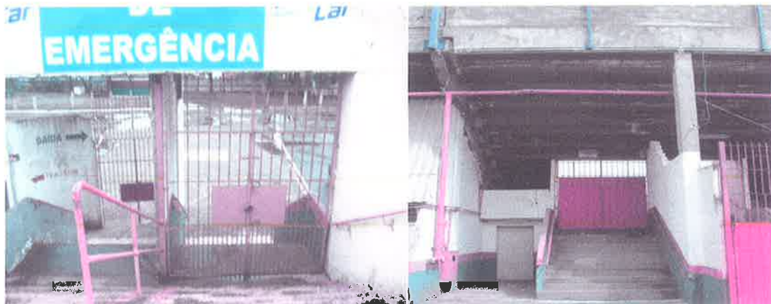
Foto 4 – Estrutura do Portão 7 Foto 5 – Estrutura do Portão 7
