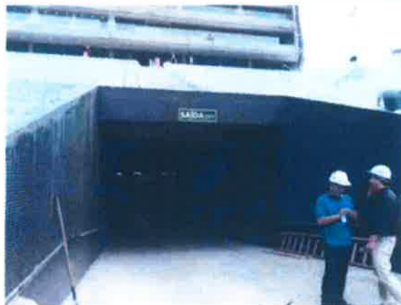
Foto 17: acesso para viaturas de emergência
