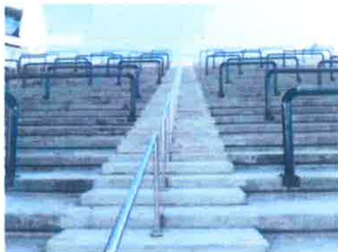
Foto 08: escada da arquibancada com corrimão
