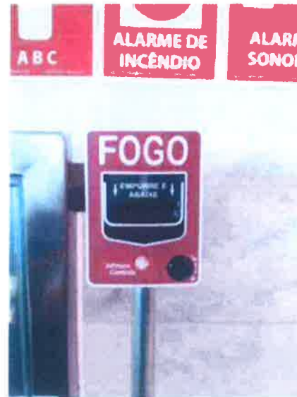
Fotos 14 e 15: botoeiras de alarme de incêndio
