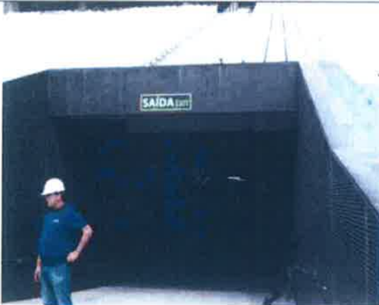
Foto 16: acesso viaturas de emergência
