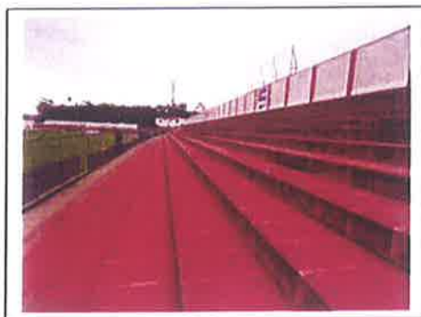
FOTO 15: VISÃO GERAL E NUMERAÇÃO APAGADA SETOR 3
