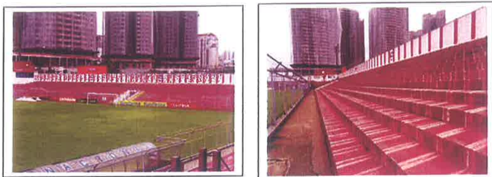
FOTOS 9 / 10: VISÃO GERAL DO SETOR 2
