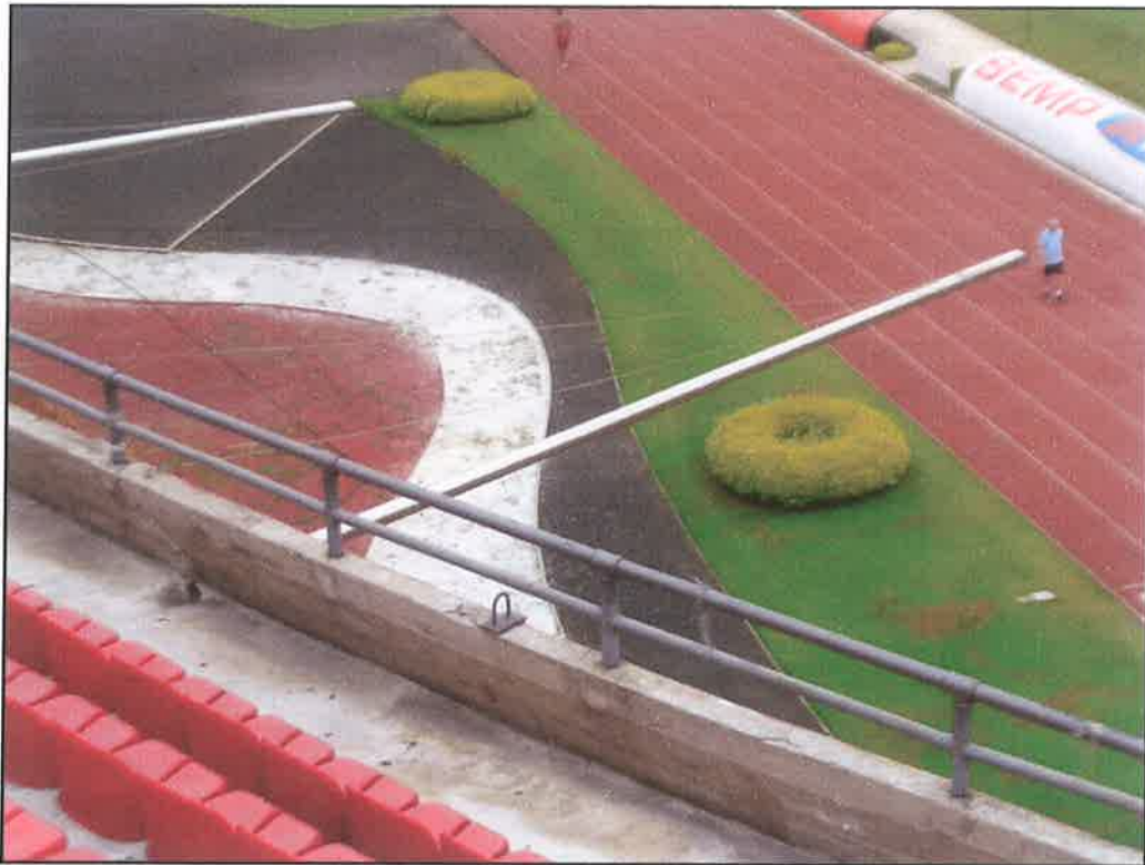
Foto 09 – Fazer revisão dos tirantes de sustentação dos buzínates.
