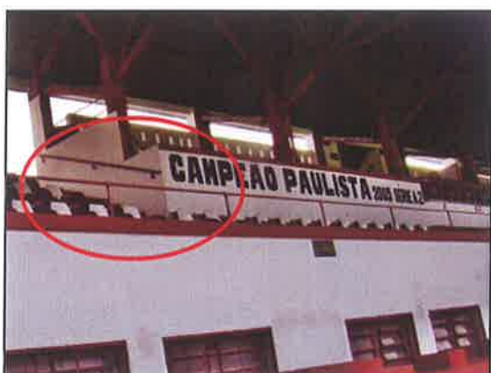
FOTOS 5 / 6: GUARDA-CORPOS FRONTAL E LATERAL
