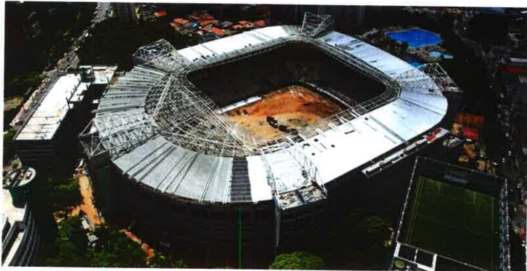
Figura 1 – Vista geral no estádio em fevereiro/2014
