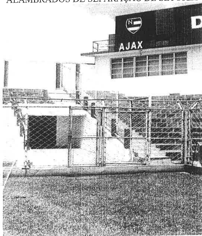
ALAMBRADOS DE SEPARAÇÃO DE SETORES
